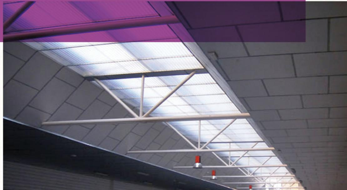
Sistema constructivo instalado debajo de la cubierta de las naves industriales y que tiene como principal objetivo el aislamiento térmico y acústico de las mismas.
